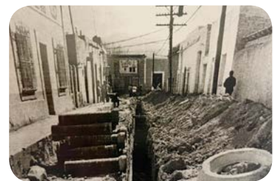
La introducción de tubería de agua y drenaje en Monclova y Frontera avanzaba, en la gráfica se muestra la calle Ildelfonso Fuentes 1966
